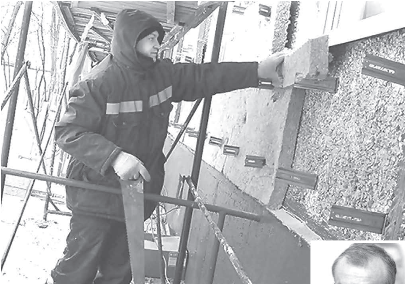
В понятие капремонта входит и «утепление и ремонт фасада дома»
